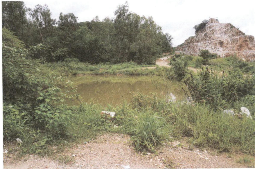
รูปที่ 6 แสดงบ่อดักตะกอน รองรับน้ำฝนที่ไหลผ่านพื้นที่ทำเหมือง
